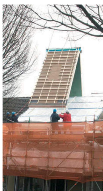
Het met een 24 cm dikke laag glaswol geïsoleerde scharnierdak werd boven op de bestaande dakstructuur geplaatst
