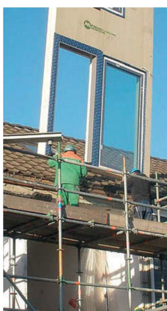
In de prefabwanden werden o.a. de ramen en nutsleidingen reeds in het atelier geïntegreerd
