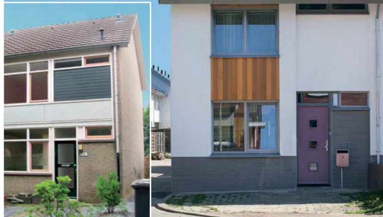
De scharnierdaken definiëren de architectuur van de wijk met hun krachtig uitstekende punten en strakke randafwerking. Bovendien verwijzen ze met hun geïntegreerde zonnecellen ook naar het energiezuinige karakter van de wijk. Het contrast met de oude situatie is groot (foto: Philip Driessen)
